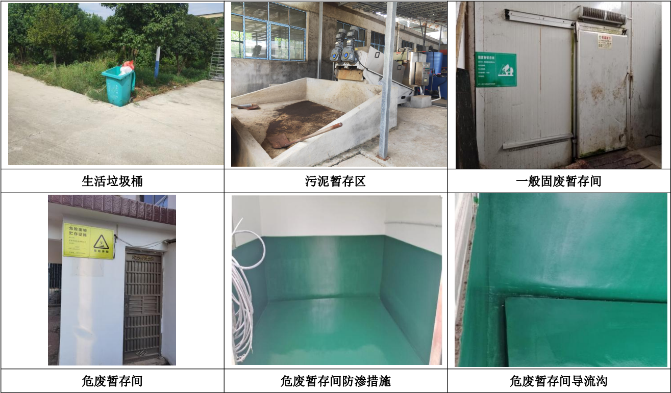
图 4-1-4 项目固废贮存情况图片
