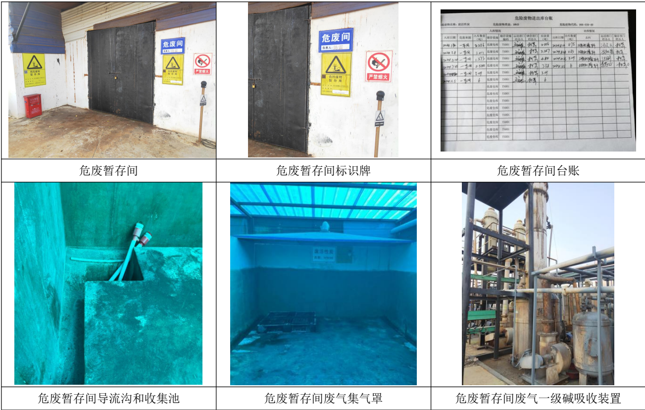
图 4.1-6 厂区危废暂存间建设图
